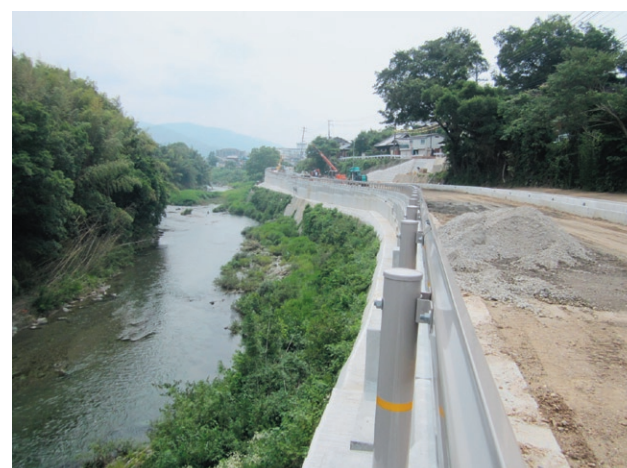
EPS盛土基礎補強
