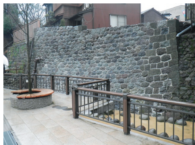
石積み合端補強とルートパイル補強
