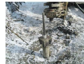
頭部完成状態
